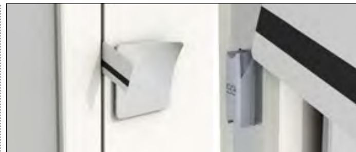
Insira um cartão de plástico na ranhura da porta na altura da fechadura, usando-o para sentir a borda superior da trinco. Em seguida, deslize a parte inferior do cartão para o recesso no lado da trinco. Agora puxe para baixo verticalmente até parar na borda da porta. O trinco agora está empurrado e a porta pode ser aberta. Apenas remova o cartão do recesso depois de abrir / Insert a plastic card in the crack of the door at the lock's height, using it to feel for the top edge of the latch. Next, slide the bottom of the card into the recess on the side of the latch. Now pull down vertically up to stop on the door edge. The latch is now pushed in and the door can be opened. Only remove the card from the recess once you have opened it / Inserte una tarjeta de plástico en la ranura de la puerta a la altura de la cerradura, usando para sentir el borde superior de la traba. A continuación, deslice la parte inferior de la tarjeta al recinto en el lado de la traba. Ahora tire hacia abajo verticalmente hasta que se detenga en el borde de la puerta. La traba ahora está empujada y la puerta puede ser abierta. Sólo retire la tarjeta del receso después de abrirla.
